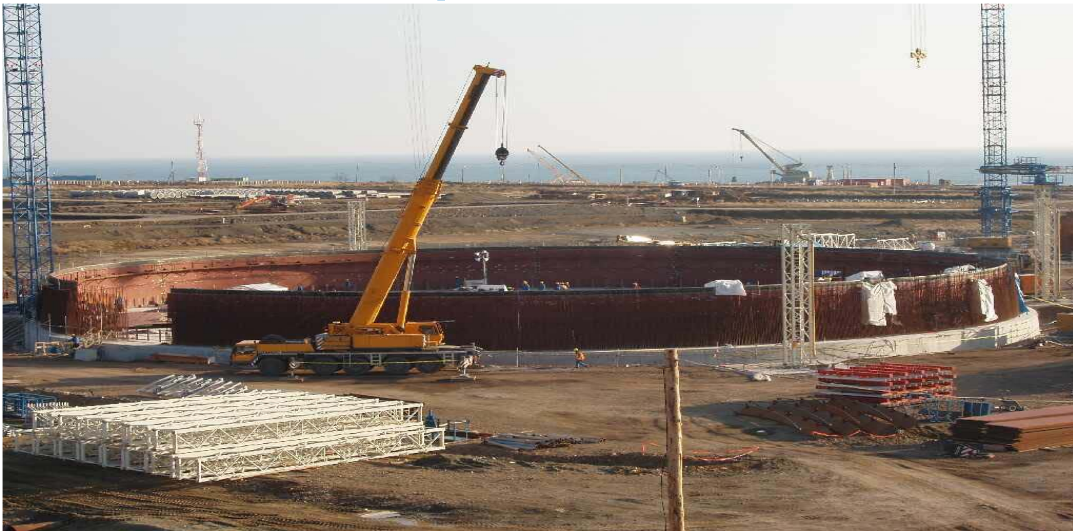
LNG Tank T-3101
