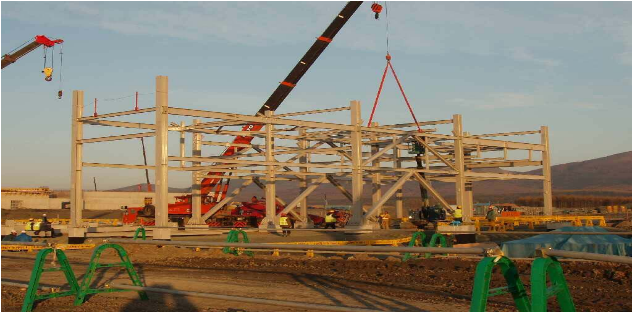
LNG Piperack PR-101
