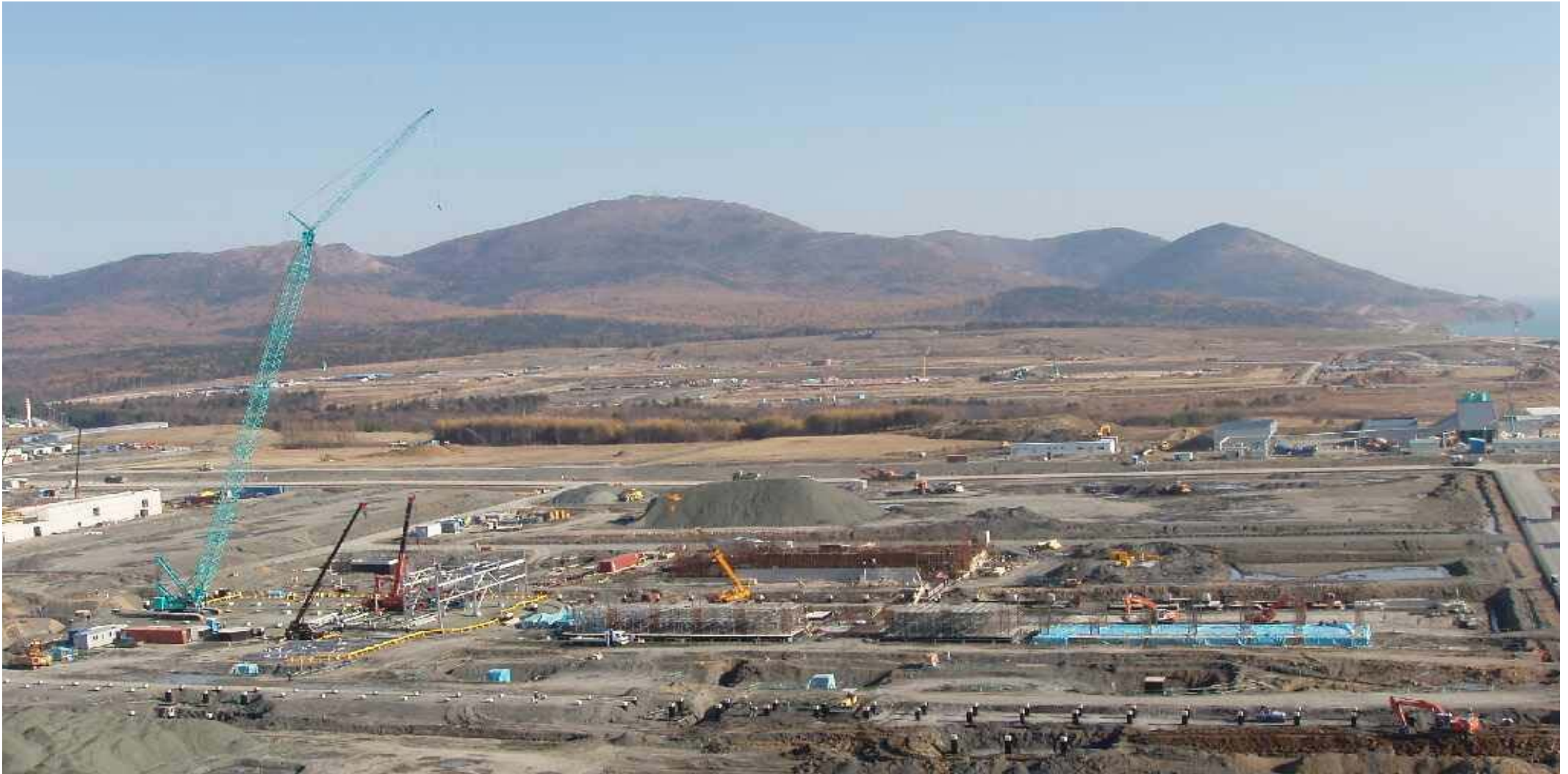
LNG Process Area
